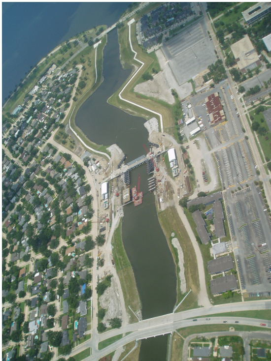
Bouw van een nieuw uitwateringsgemaal in het London Avenue Canal bij Lake Pontchartrain. FOTO: ROYAL HASKONING
